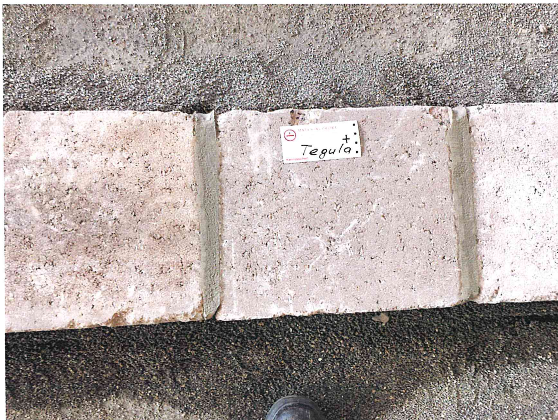
Bild 1. Die zu prüfende Pflasteroberfläche TEGULA im aufgebauten Zustand.
