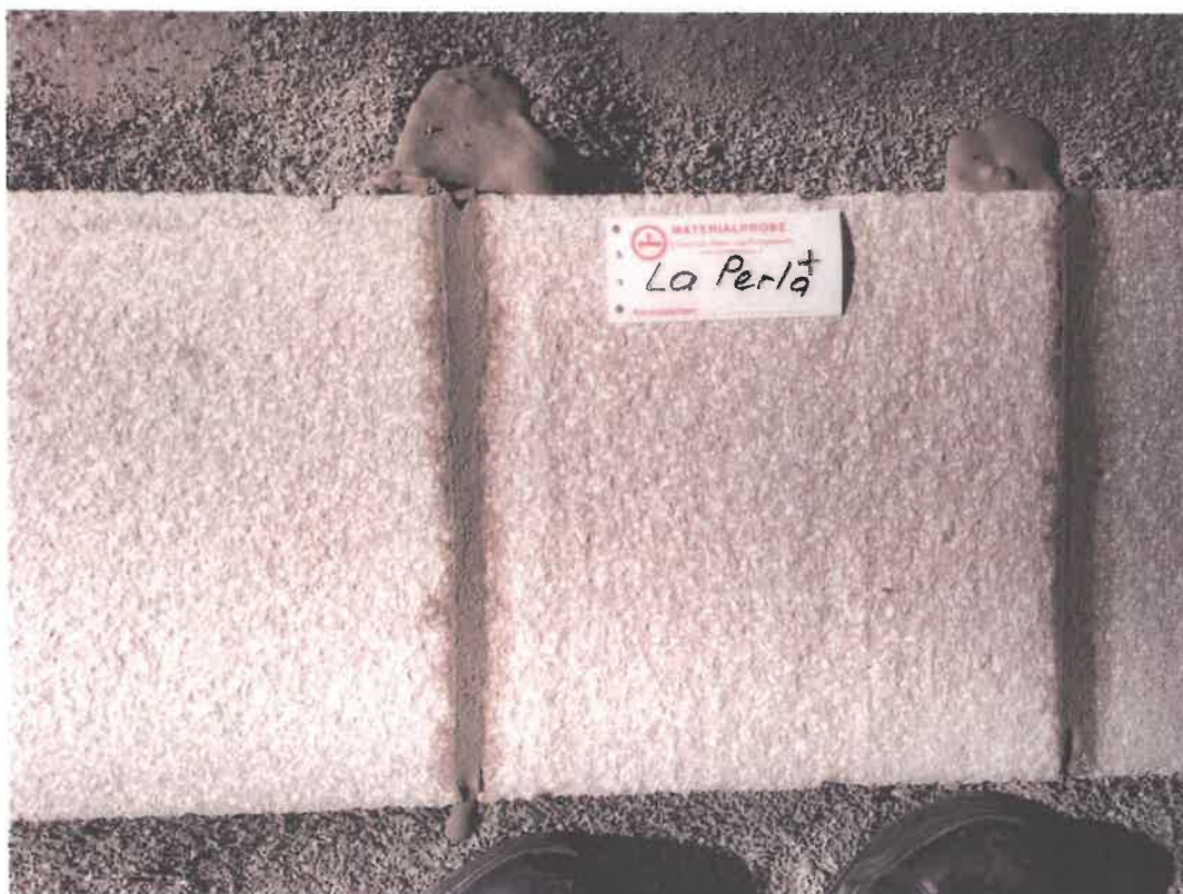
Bild 1. Die zu prüfende Pflasteroberfläche LA PERLA im aufgebauten Zustand.
