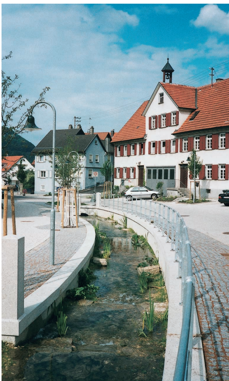
Objektbezogene TESCADO-Rezeptur für das Pflaster rechts und links der Gos
