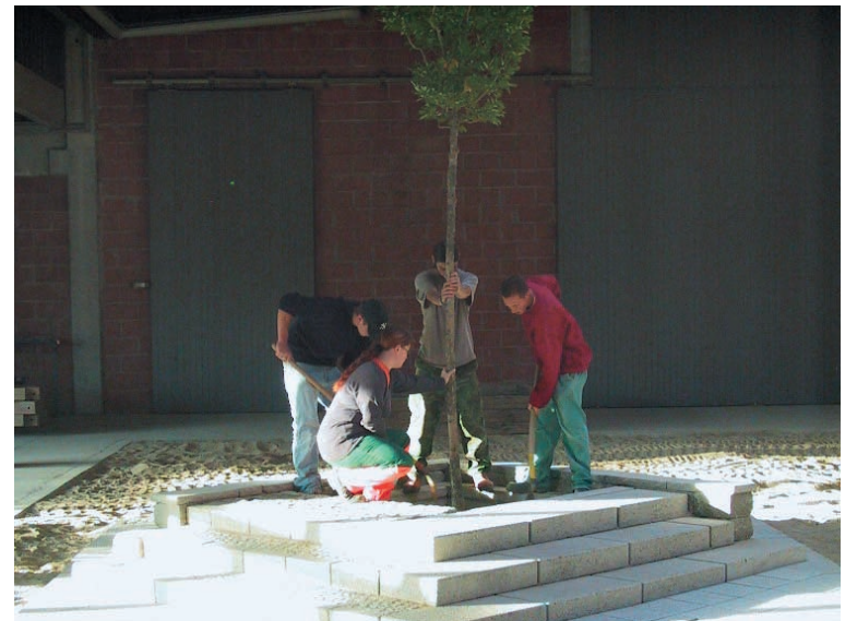
Einbau eines ARPANA®-Baumquartiers
