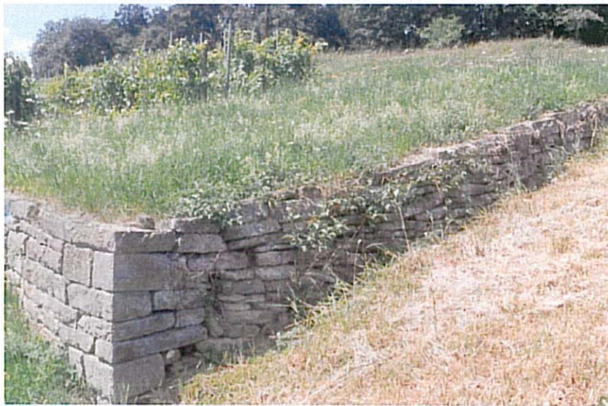
Abb. 27 Tagsüber beschattete Staffelmauer (Mauer 6-3, Foto MÜNCH 15.7.2008).
