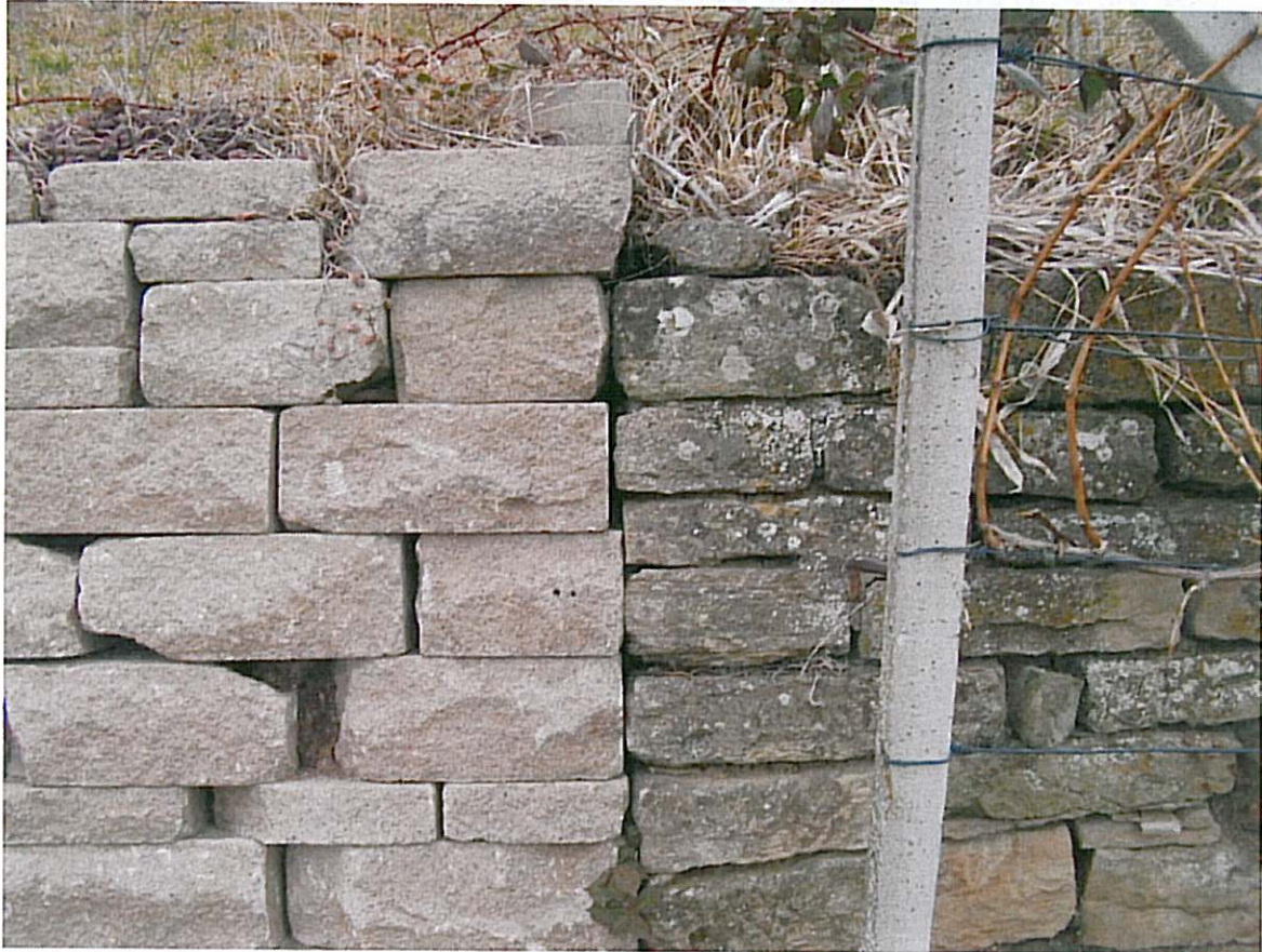
Abb. 6 Vergleich einer SANTURO®-Mauer zu einer angrenzenden älteren Natursteinmauer mit deutlichem Flechtenbewuchs.
