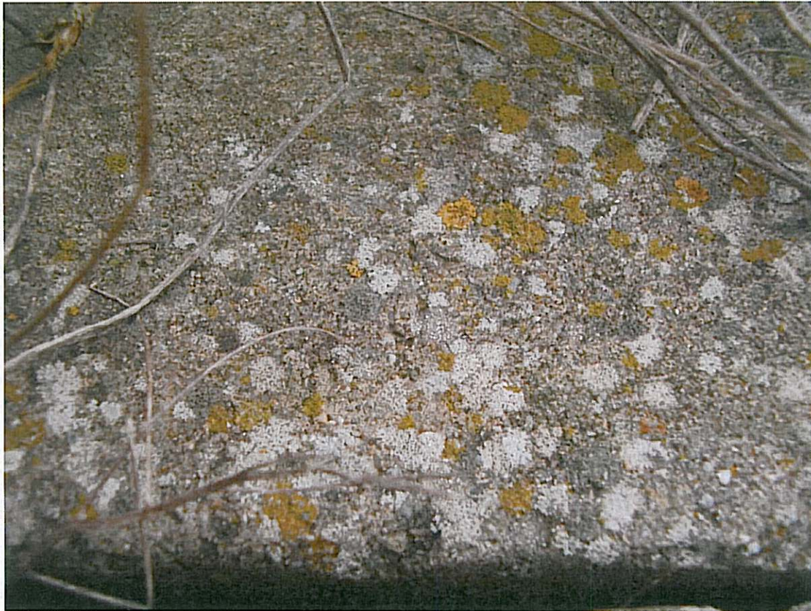
Abb. 7 SANTURO®-Mauerkrone mit artenreichem Pionierflechtenbewuchs.
